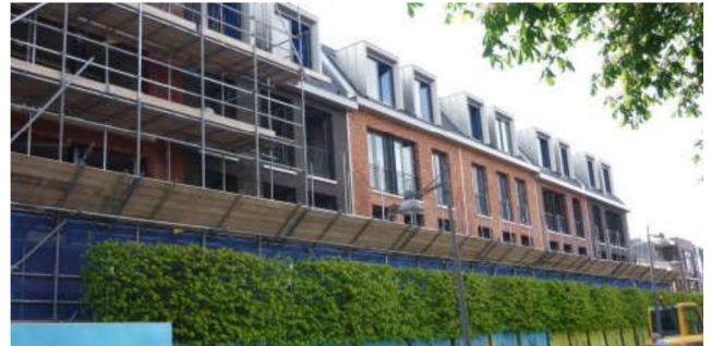
Voorbeeld van opvangconstructie gevelsteiger
